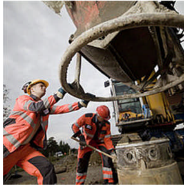
Constructeur de fondations CFC
