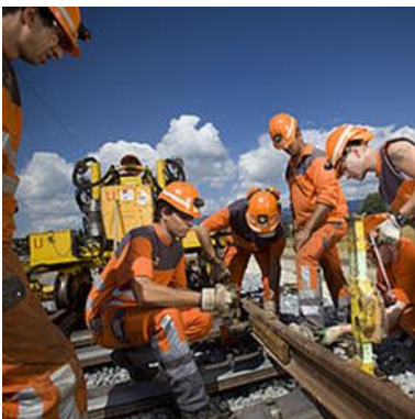
Costruttore di binari AFC
